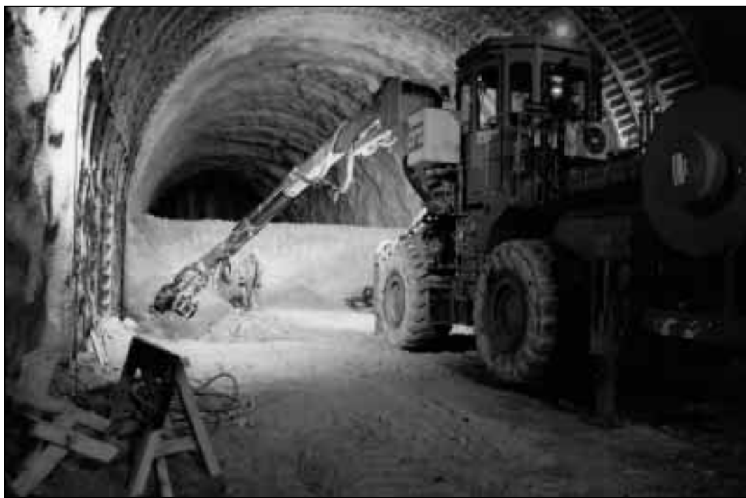
Creusement en demi-section
