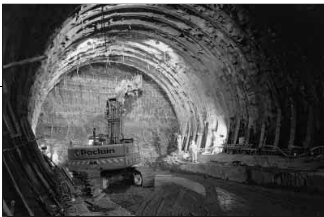
Creusement en pleine section
