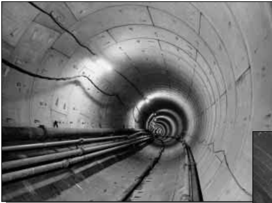
Revêtement par voussoirs en béton
