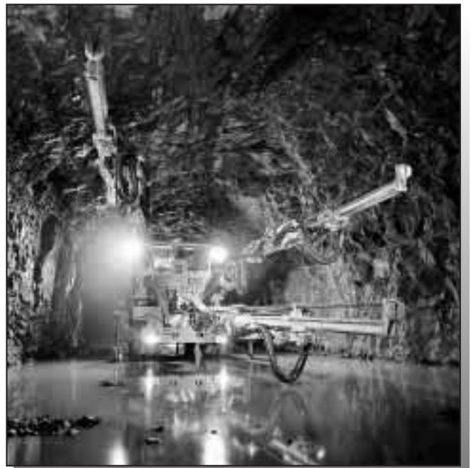
Perforatrice au front de taille
