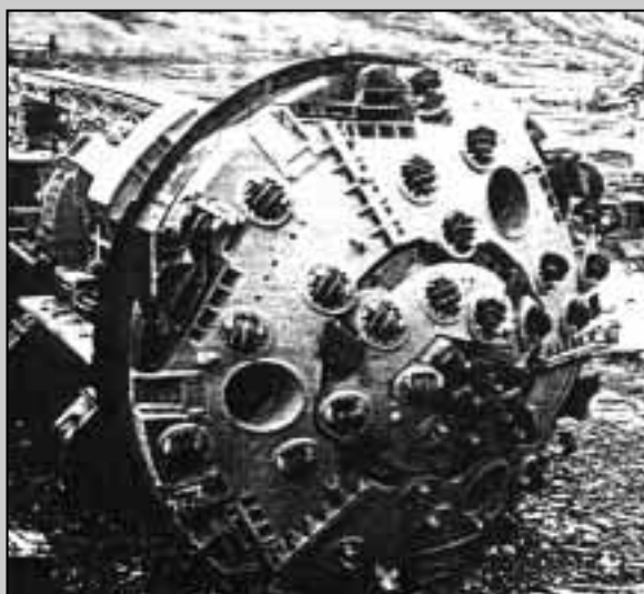
Tunnelier WIRTH Ø 5m58 (Galerie de Belledonne - 1974)
