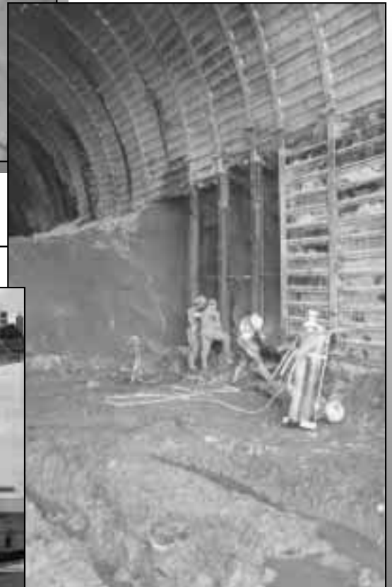
Soutènement par blindage
