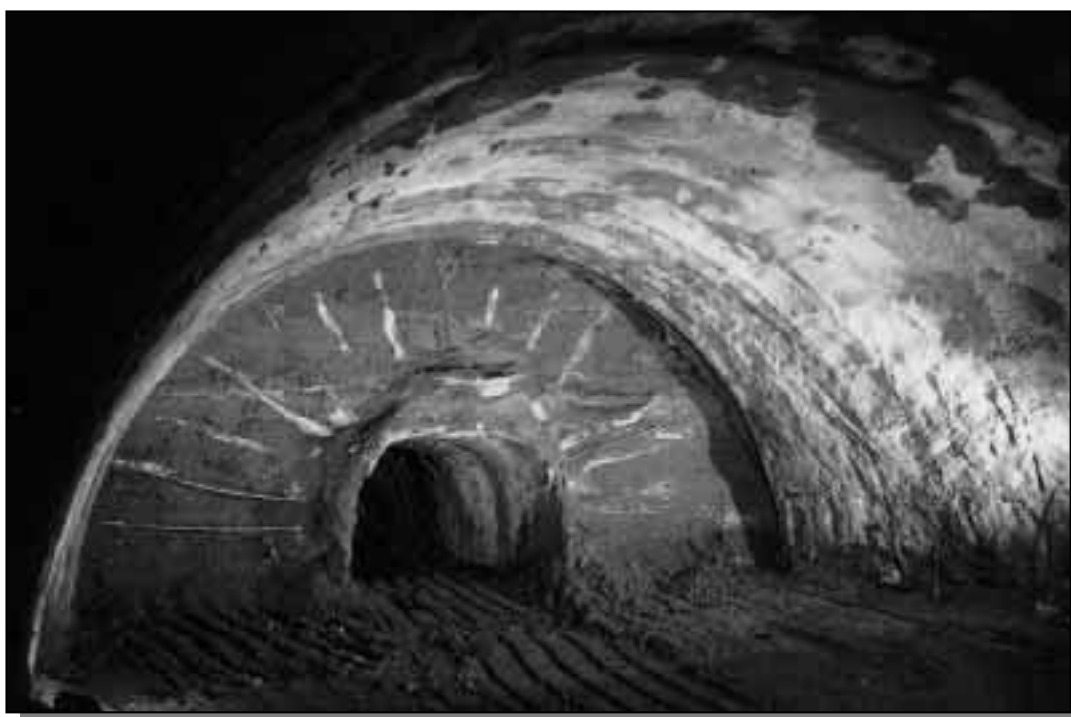
Exemple de galerie-pilote pour traitement du terrain
